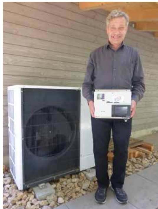
Horst Grüning mit dem eigenentwickelten Steuerungselement, hinten eine Ausseneinheit von Mitsubishi. Bild: zvg
