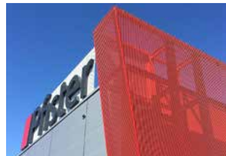
Eine Verkleidung aus Edstahlgewebe für Fluchtbalkone verhindert, dass Menschen von dort abstürzen. Bild: WZV/GKD
