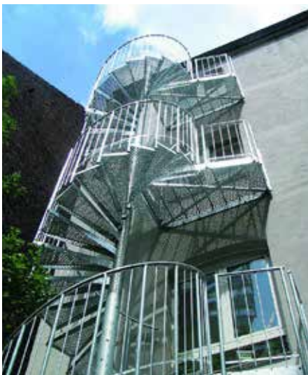
Bei der Gestaltung von Fluchttreppen übernimmt Edelstahl Rostfrei eine Schlüsselrolle. Bild: WZV/PCP. Sicherheitsroste
