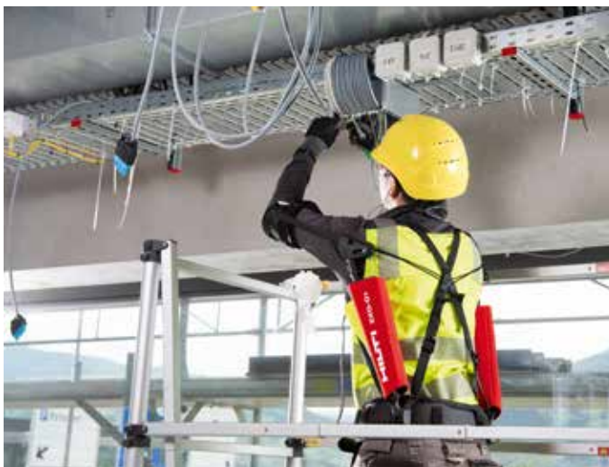
Anwendungsbeispiel: Das Hilti EXO-O1 entlastet den Anwender bei seriellen Schraubarbeiten, die über der Schulter oder über dem Kopf ausgeführt werden müssen. Bild: Hilti
