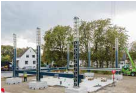
PERI druckt das erste Wohnhaus Deutschlands mit dem Portaldrucker BOD2. Bild: PERI
