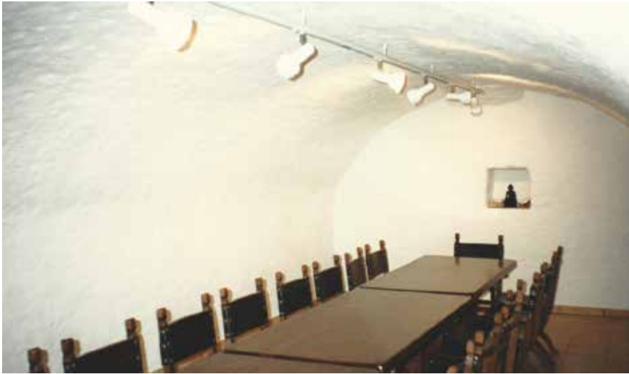
Jahre nach Mauerentfeuchtung/-Sanierung: Immer noch trockenes, sauberes Mauerwerk. Bild: Anderegg Mauerentfeuchtung GmbH
